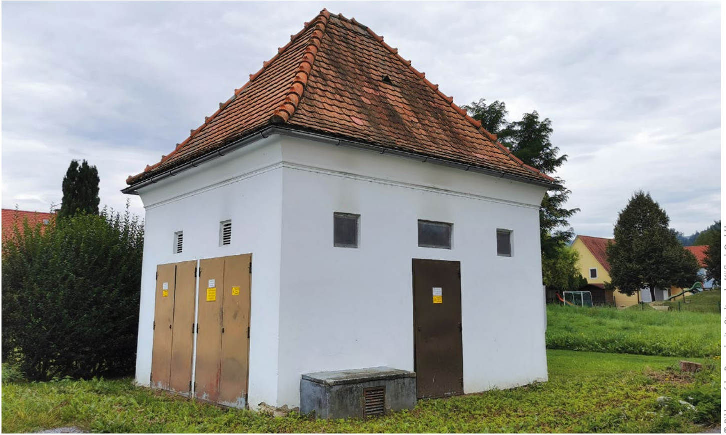
Trafohäuschen gehören in der Steiermark noch immer zum Landschaftsbild – hier die Trafostation Ostsiedlung
