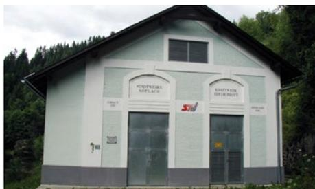
am 31. Dezember 1910 nahm das gemeindeeigene Kraftwerk unter dem damaligen Bürgermeister Franz Kautschitsch seinen Betrieb auf. Im Jahr 1994 wurde es umgebaut und auf den aktuellen Stand der Technik gebracht. Das Kraftwerk hat nun eine Engpassleistung von 1.300 kW und erzeugt bis zu 4.000 MWh jährlich, die angebundene Restwasserturbine bis zu 80.000 kWh.
