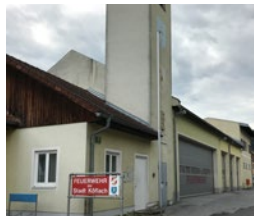
Rüsthause mit intakter Notruf - Alarmierungskette
