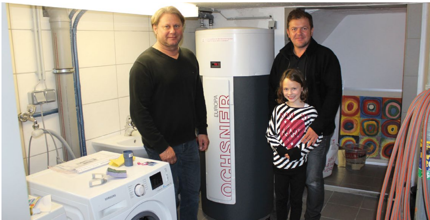
Voll stolz präsentiert Familie Zupan gemeinsam mit ihrem fairsorger-Kundenberater die neue Wärmepumpe: Die Heizkosten haben sich stark verringert, und durch den geringen Platzbedarf der Anlage hatte sie auch in dem recht kleinen Kellerraum gut Platz.
